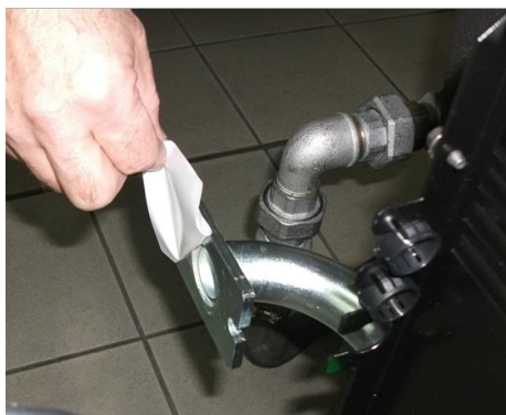
7) Снять заглушку из Труба ГАЗОВОЙ ramпы;
