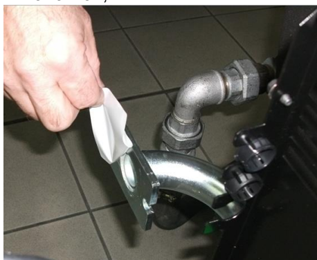
7) Снять заглушку из Труба ГАЗОВОЙ рампы;
