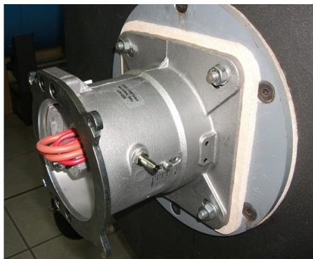
2) Смонтировать Смесительную Группу на котле;
