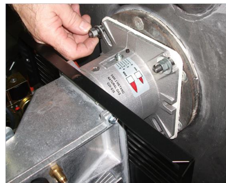
6) Зафиксировать горелки на котел;
